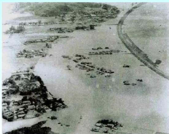
右岸大塚町付近の浸水状況（宮崎市）
